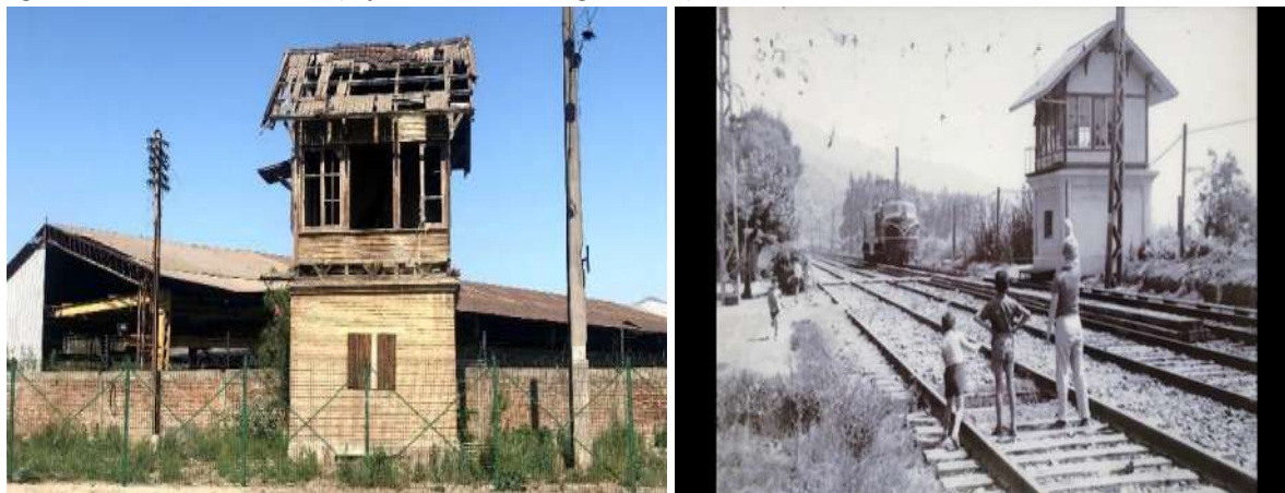
Figura N°12: Caseta Ferroviaria (Faja ferrocarril Santiago-Batuco)
