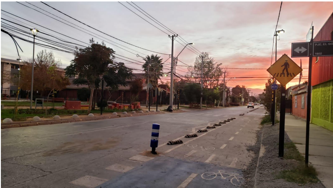
Imagen 12. Fotografía del mejoramiento de Av. Balmaceda entre Apostol Santiago y Caupolicán
