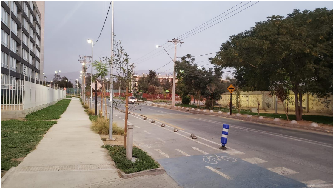
Imagen 13. Fotografía del mejoramiento de Av. Balmaceda entre Apostol Santiago y Caupolicán
