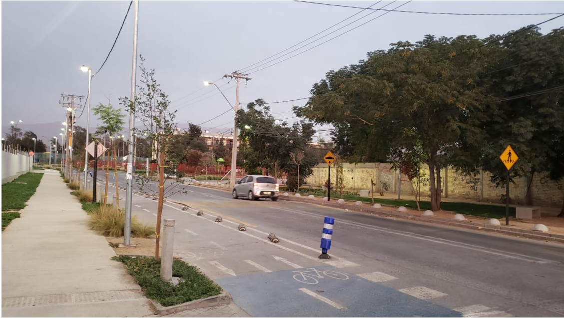
Imagen 11. Fotografía del mejoramiento de Av. Balmaceda entre Apostol Santiago y Caupolicán
