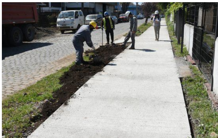
Fig. 31. Imagen referencial de veredas de hormigón
